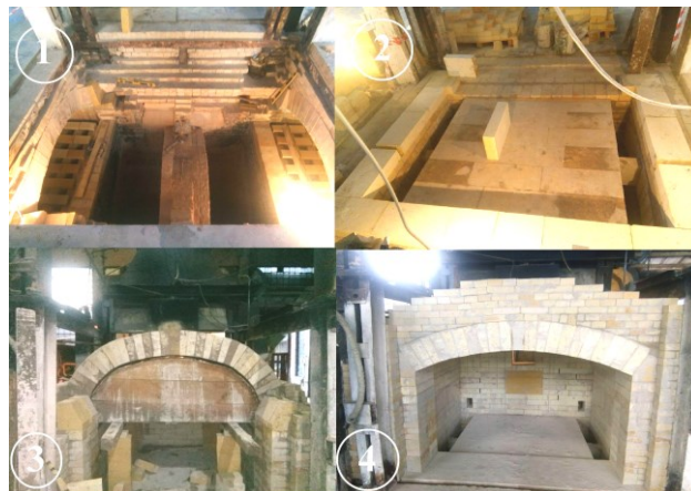
Рис. 5 – Основні етапи капітального ремонту регенеративної печі
